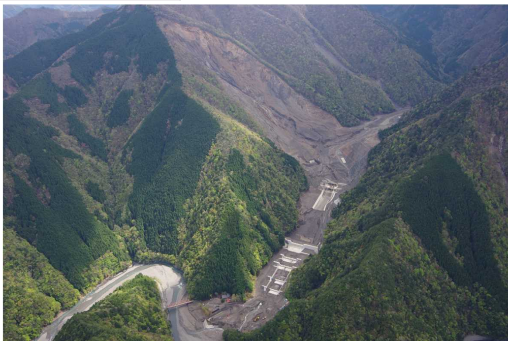
●川原樋川床固工群(奈良県五條市)
