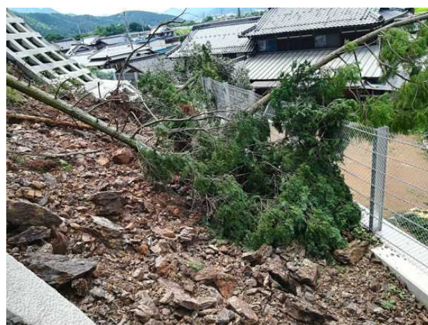
●待受擁壁工により崩壊土砂等を捕捉し家屋を保全
