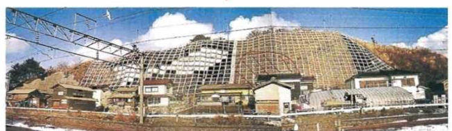
●吹付工改築(新潟県岩船郡山北町)
