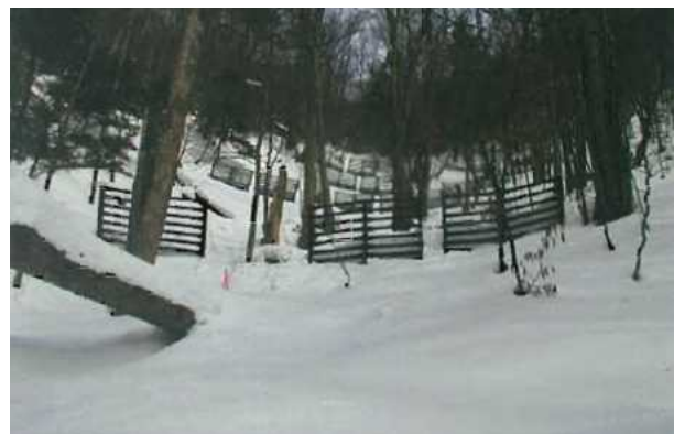
● 雪崩予防柵工(長野県松本市安曇)
