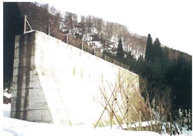
● 雪崩防護擁壁(富山県南砺市利賀村)
