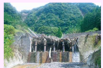
●土石流を止めた砂防堰堤 (熊本県阿蘇市)
