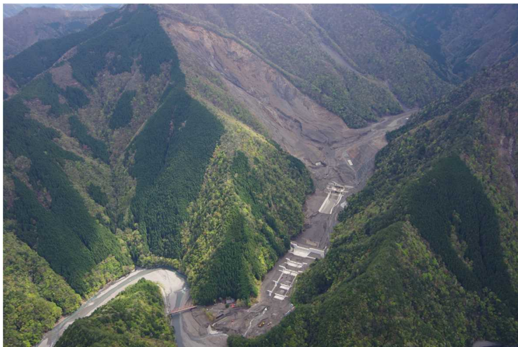
●川原樋川床固工群(奈良県五條市)
