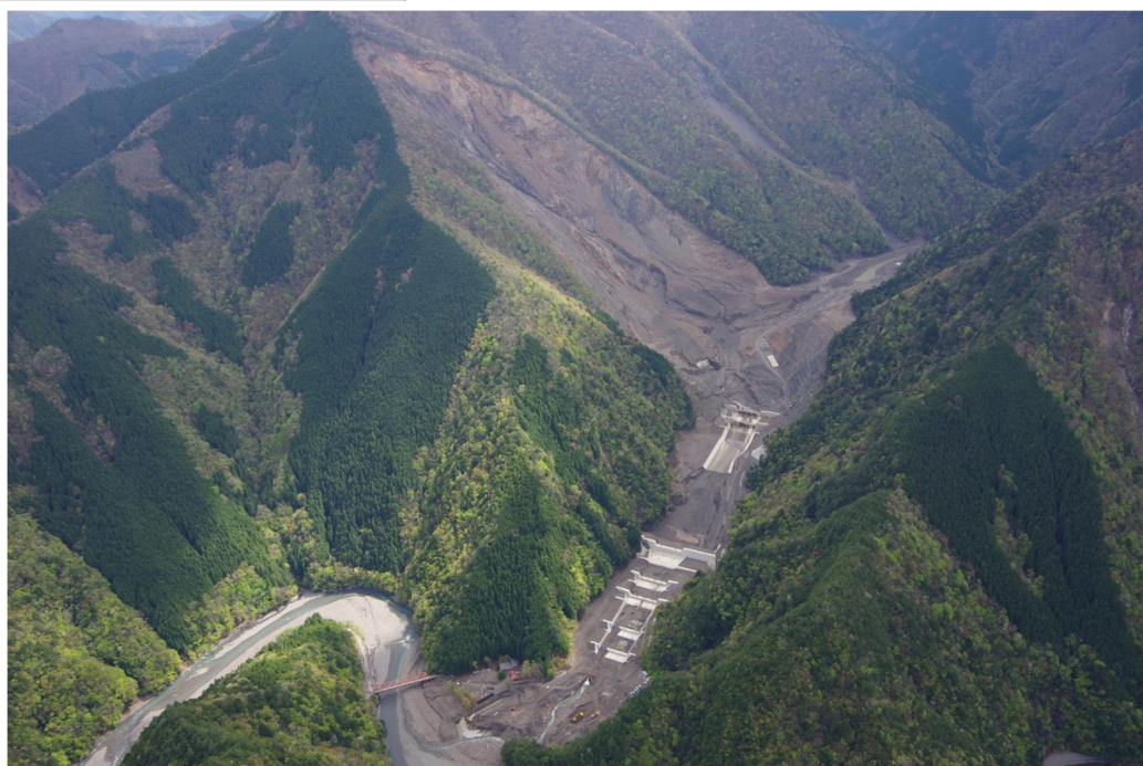
●川原樋川床固工群(奈良県五條市)
