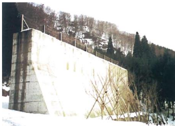
● 雪崩防護擁壁(富山県南砺市利賀村)
