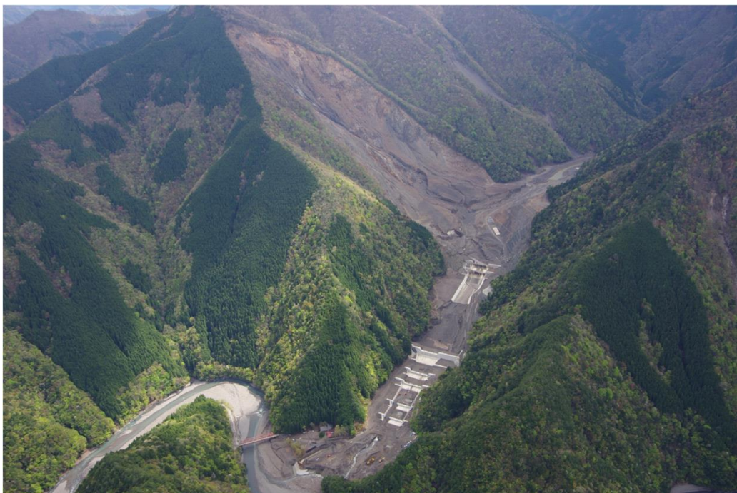
●川原樋川床固工群(奈良県五條市)
