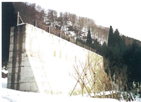
● 雪崩防護擁壁(富山県南砺市利賀村)
