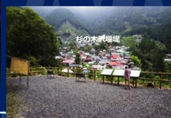
展望台からの砂防堰堤を望む (有東木道プロジェクト)
