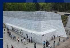
ホルタリングウォール (水沢第2砂防堰堤)
