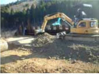
**ソイルセメント工完了(締固)写真**
