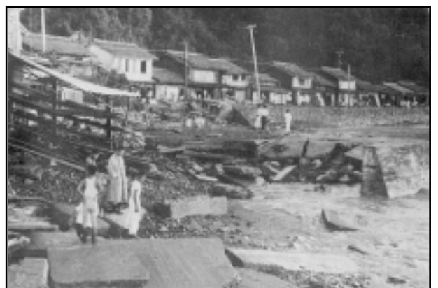
護岸築堤決壊 (三重県海山町)
