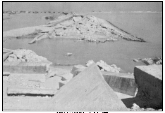
海岸堤防の決壊 (三重県川越村亀崎新田)
