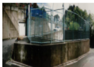
従前の防災調整池 (約500m 3 規模)
