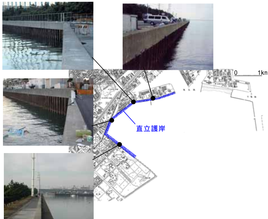
図 2.9.1-16 市川側護岸の状況
