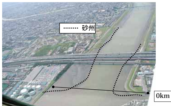
写真 3.2-2 江戸川放水路河口部(0km)の砂州の状況 (行徳可動堰閉鎖 1 日後 (7/14) 干潮時頃の撮影)
