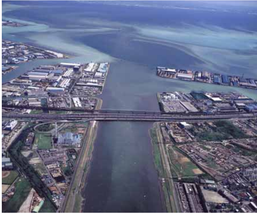
写真 3.4-1(1) 青潮の発生状況 (H14.8.20 撮影) <江戸川放水路河口部、市川、船橋浅海域>
