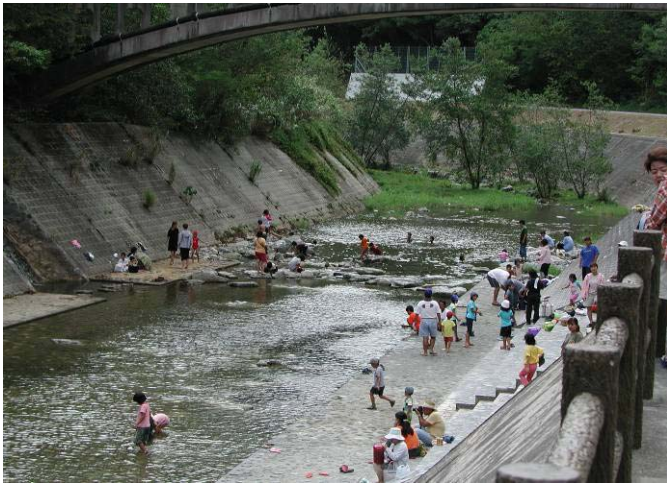
福地ダム（沖縄県） 水遊び
