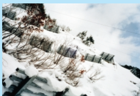
雪崩予防柵 (福島県耶麻郡西会津町)
