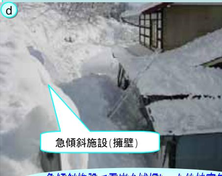
急傾斜施設で雪崩を捕捉し、人的被害無し
