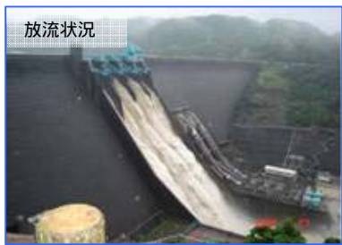
計画規模を超える洪水に見舞われた鶴田ダムの放流状況
