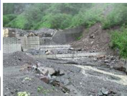
白谷第6号砂防堰堤から下流の堰堤群で大量の土砂を捕捉!! H18.7.21現在
