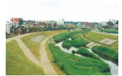
鳥類の営巣に配慮した草刈りの工夫（根木名川） 5)
