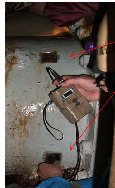
放流管の鉄管厚測定状況
