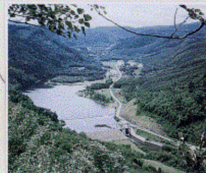
ムリ セトセ 武利ダム（瀬戸瀬発電所）
