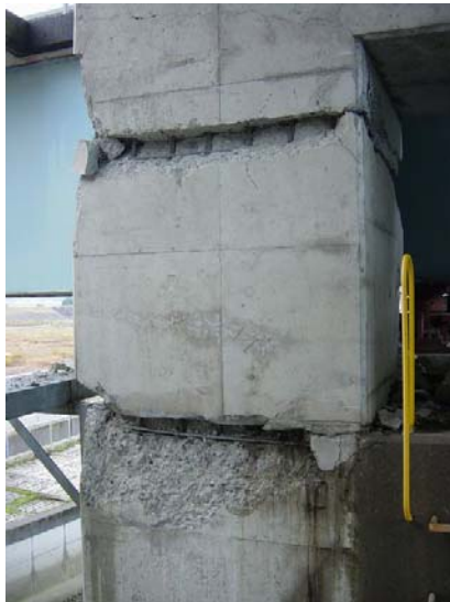
平成16年新潟県中越地震 信濃川妙見堰
