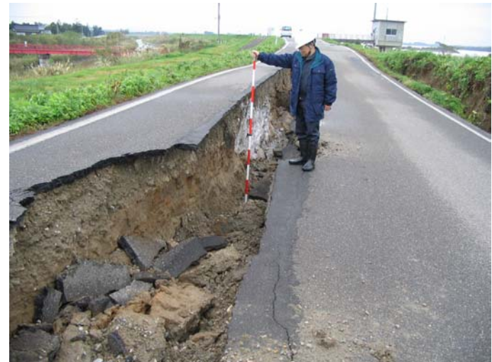
平成16年新潟県中越地震 信濃川
