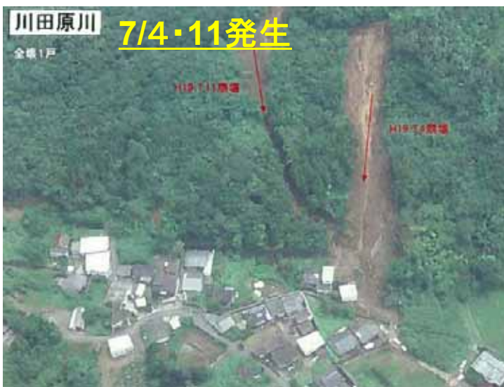
川田原川 7/4・11発生 全壊1戸 ↑ 鹿児島県 肝属郡 南大隅町 郡 川田原
