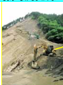
無人化施工（岐阜県施工） ～岐阜県揖斐川町東横山地すべり～ ぎふけん いひかわちょう ひがしよこやま
