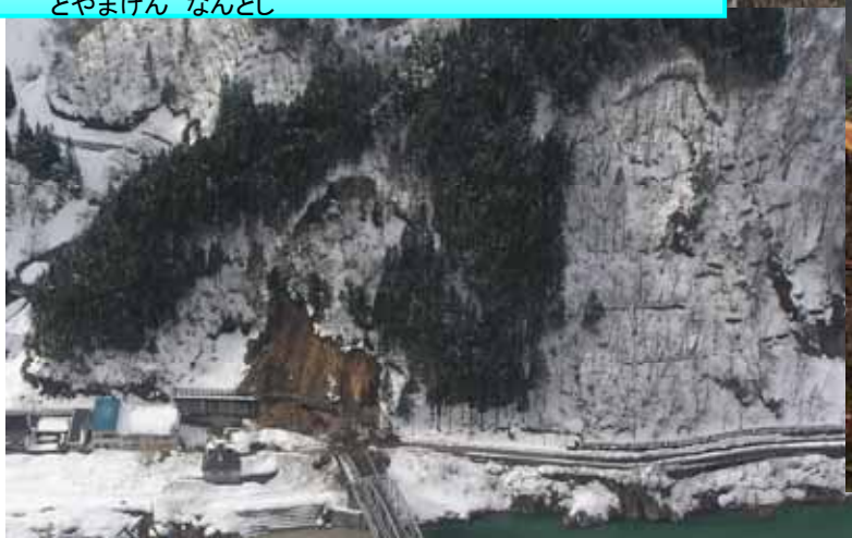
無人化施工（富山県施工） ～富山県南砺市国道156号地すべり～ とやまけん なんとし
