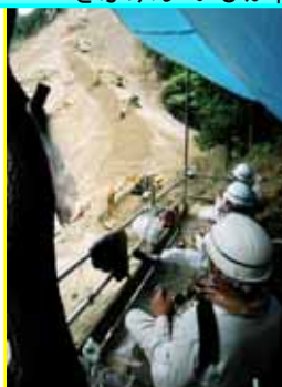
無人化施工（岐阜県施工） ～岐阜県揖斐川町東横山地すべり～ ぎふけん いひかわちょう ひがしよこやま
