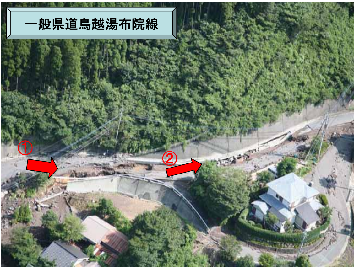
①ブロック積み及び路面の被災
