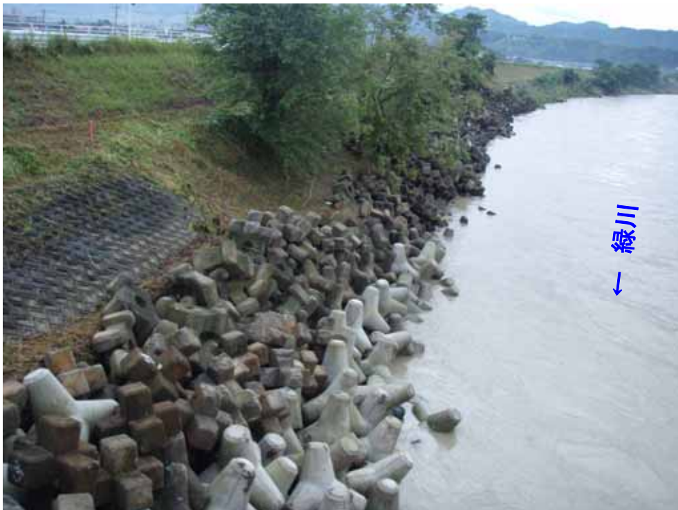
緊急復旧完了 (7月10日)
