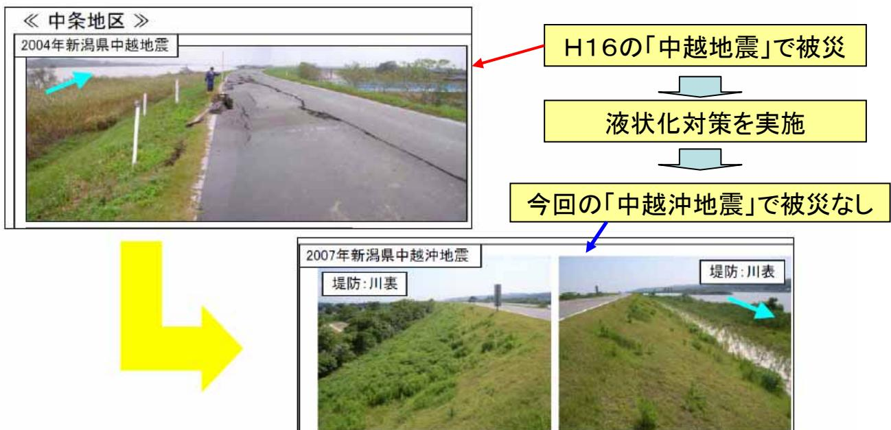
信濃川は平成16年の中越地震でも堤防などに大きな被害を受けています。町軽井地区のほぼ対岸にあたる**中条地区**でも**液状化**により**堤防が大きく変状**する被害を受けています。しかし、**復旧**にあたっては**液状化対策**も考慮した**復旧**を実施しているため、**今回の地震では大きな被害はありませんでした。**
