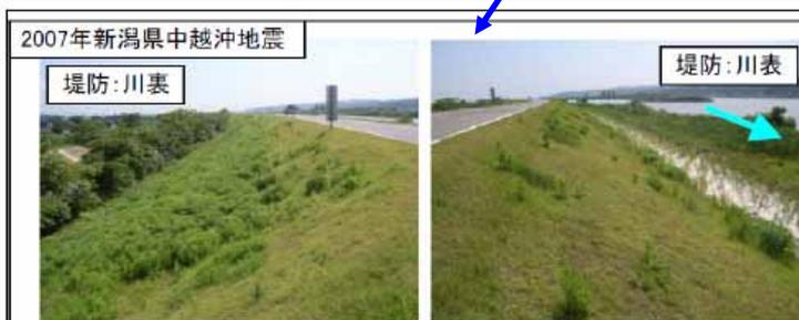
信濃川は平成16年の中越地震でも堤防などに大きな被害を受けています。町軽井地区のほぼ対岸にあたる**中条地区**でも**液状化**により**堤防が大きく変状**する被害を受けています。しかし、**復旧にあたっては液状化対策も考慮した復旧を実施しているため、今回の地震では大きな被害はありませんでした。****町軽井地区の復旧にあたっては、中条地区と同様に液状化も考慮した対策を実施し、再度災害の防止に努めます**
