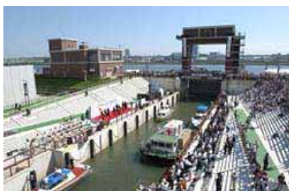
写真 3.2 荒川ロックゲート
