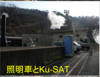
監視カメラ・照明車配備位置
