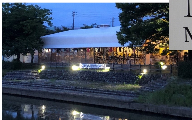
階段式護岸とバーベキューテント
