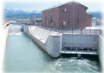
七ヶ用水発電所(手取川水系手取川) (有効落差5.45m、最大出力640kW)
