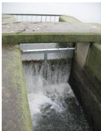
写真- スクリーンへの塵芥付着による流量減少の事例
