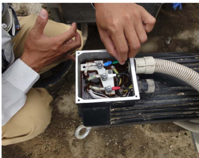
写真- 出水時の水没で発電機が漏水し故障した事例
