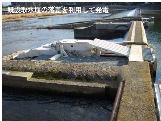
嵐山小水力発電所（淀川水系桂川）
