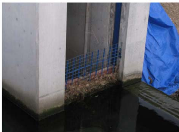
写真- スクリーンへの塵芥付着による流量減少の事例
