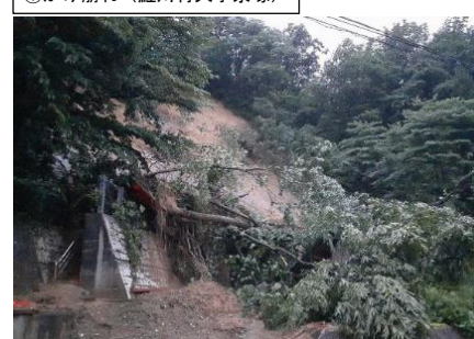
①がけ崩れ(鮭川村大字京塚)
