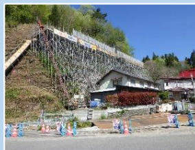
住宅地と隣接した現場での仮設計画見直し
