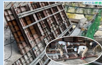
雨天休工時に屋内で大型型枠の組立作業を実施
