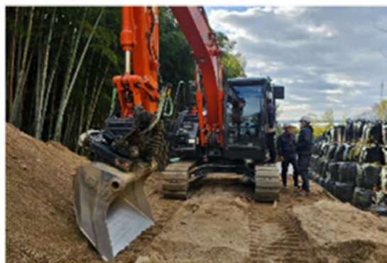
チルトロータを搭載した ICT重機の活用
