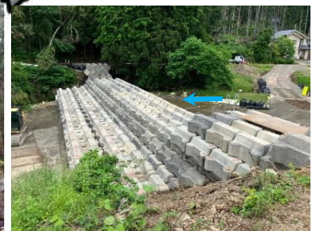
応急対策工事状況（鈴屋川(牛尾川)） ブロック堰堤設置完了
