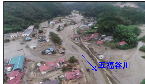
令和元年台風19号(宮城県丸森町)
