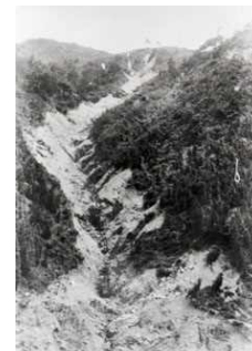
阪神大水害時の土砂生産(昭和13年)
