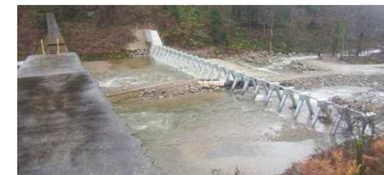
例: 大量流下する流木の捕捉施設の設置
