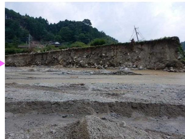
H29 九州北部豪雨 福岡県・朝倉市赤谷川
