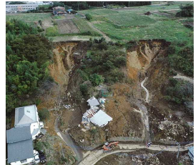
2019/10/12 令和元年東日本台風 群馬県富岡市 内匠地区 (若井ほか, 2020)
