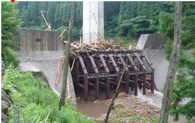
透過型砂防堰堤
