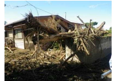
流木による家屋の損壊
