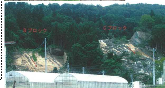
2007/7/16 平成19年新潟県中越沖地震 新潟県柏崎市米山町聖ヶ鼻 (小荒井ほか, 2008)
