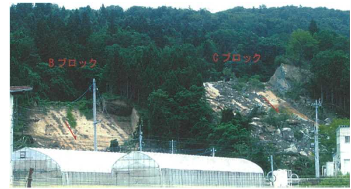
2004/10/23 平成16年新潟県中越地震 新潟県小千谷市横渡 （伊藤ほか, 2009）
