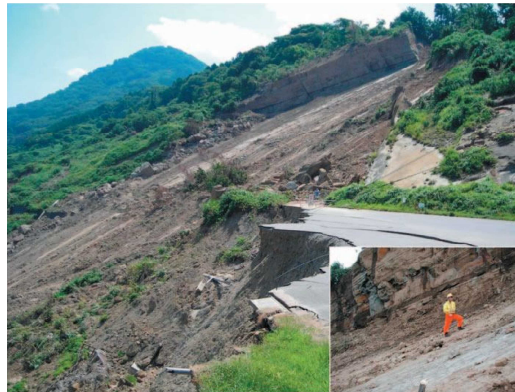
2007/7/16 平成19年新潟県中越沖地震 新潟県柏崎市米山町聖ヶ鼻 （小荒井ほか, 2008）
