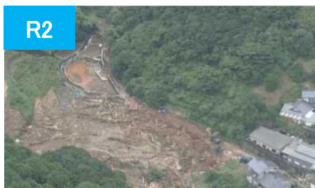
R2 令和2年7月豪雨(熊本県津奈木町)
