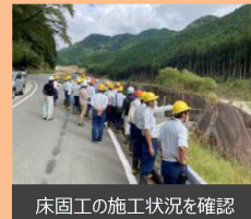
床固工の施工状況を確認
