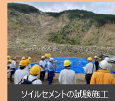
ソイルセメントの試験施工
