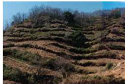
裸地斜面等における植栽の実施
