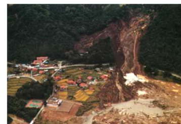
1984/9/14 昭和59年長野県西部地震 長野県木曽郡大滝村滝越 死者1名（長野県土木部, 1984）
