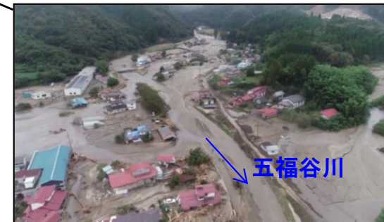
令和元年台風19号(宮城県丸森町) 9
