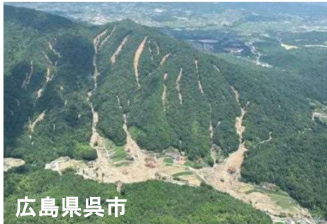
同時多発的な土石流
