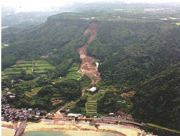
写真－1 船石川斜め写真（7月7日国土交通省九州地方整備局撮影）
