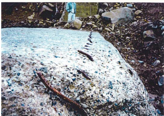
写真-4.2 袖部被災状況
