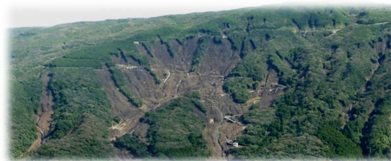
大量の流木の発生源(東京都伊豆大島)
