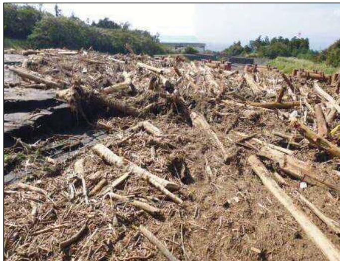
八重沢堆積工
