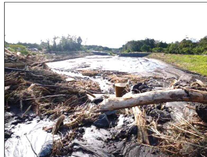
大金沢本川堆積工
