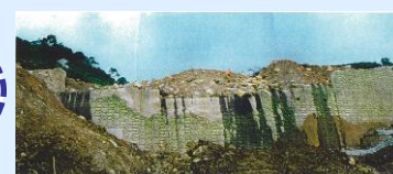
計画規模以上の土石流を受けたが倒壊せず減災効果を発揮した堰堤 (鹿児島県出水市針原地区)
