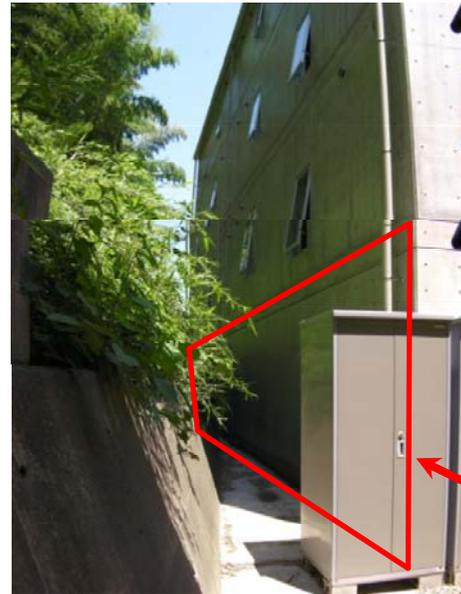
土砂災害特別警戒区域内に位置するため、壁式鉄筋コンクリート構造で、窓の無い構造とした
