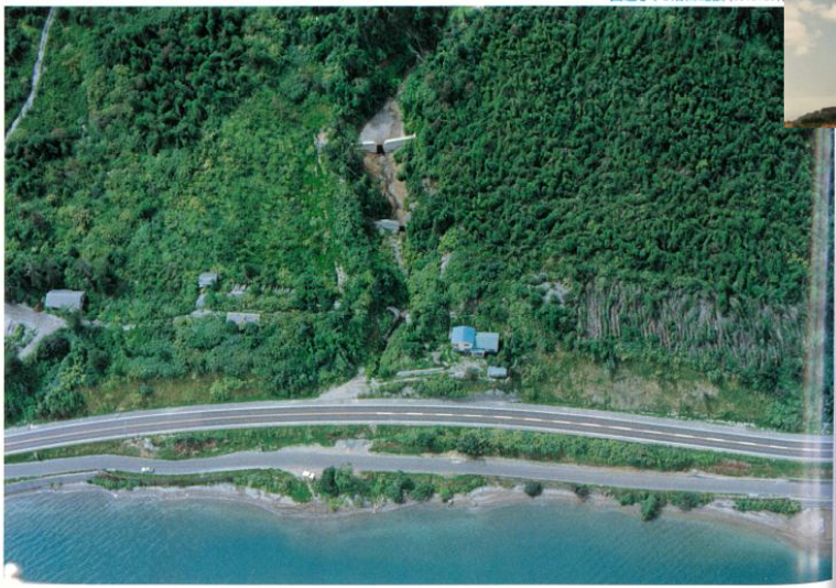
土石流発生地点（月浦地区）
