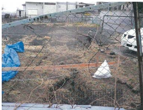
被災状況 (宮城県仙台市)
