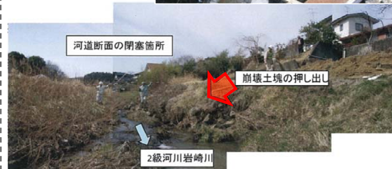
特に顕著な崩壊ブロックの滑落崖
