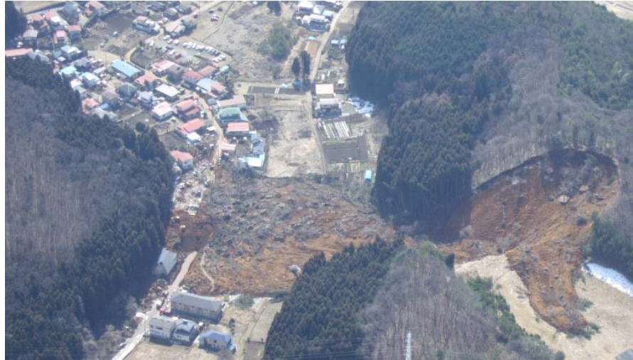
福島県白河市葉ノ木平地区の土砂災害
